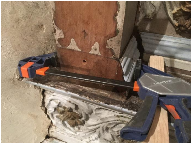
Collage et fixation par vis des éléments de moulure
