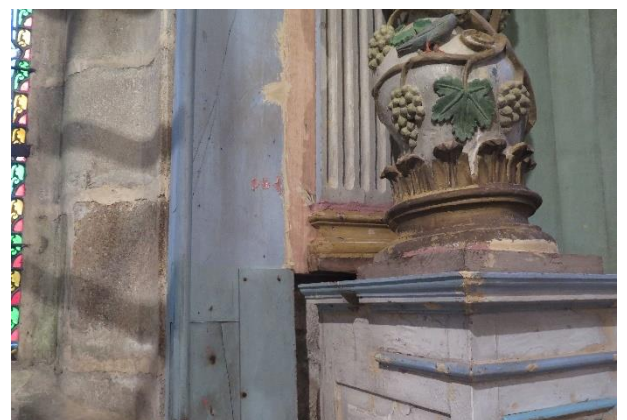
Changement de la planche de chêne servant de support au pilastre à l'arrière de la colonne de droite qui était complètement dégradée par les champignons. Elle a été fixée sur des tasseaux boulonnés à la maçonnerie. Puis le pilastre a été refixé par des vis.
