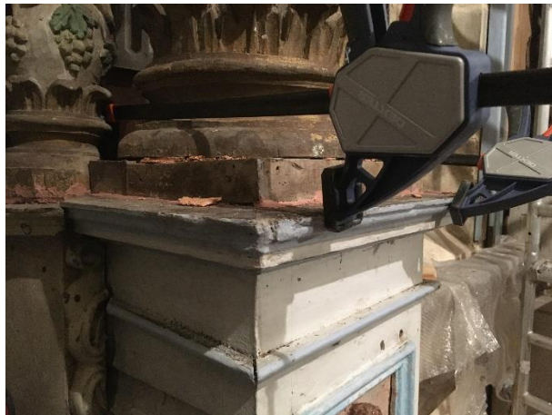
Collage et fixation par vis des éléments de moulure
