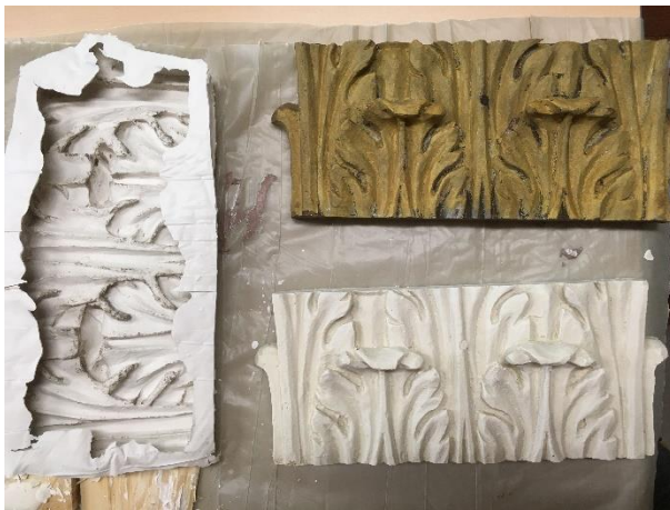
Complément du chapiteau de pilastre droit prise d'empreinte sur celui de gauche, tirage en plâtre, fixation par vis et ajustements à la résine.
