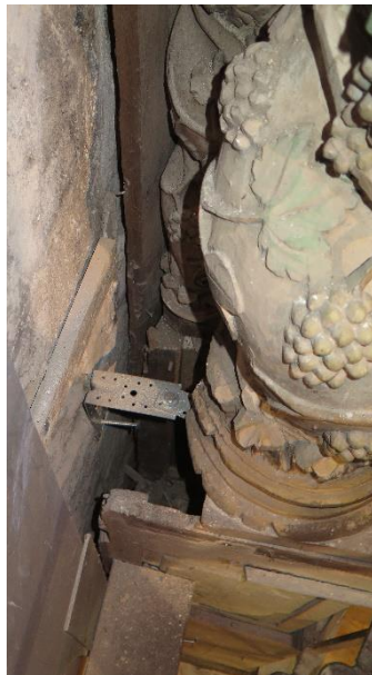
Mise en place d'une équerre métallique en soutien à la colonne
