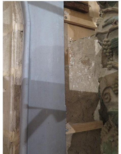
Mise en place de tasseaux / boulonnés à la maçonnerie pour fixation du pilastre
